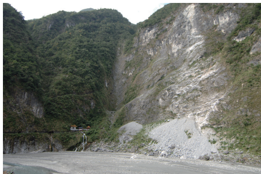
照片1 長春祠的岩層具有發達的節理與受立霧溪侵蝕作用影響，容易造成落石、崩塌
