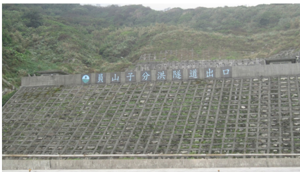
照片6 員山子分洪道隧道出水口
