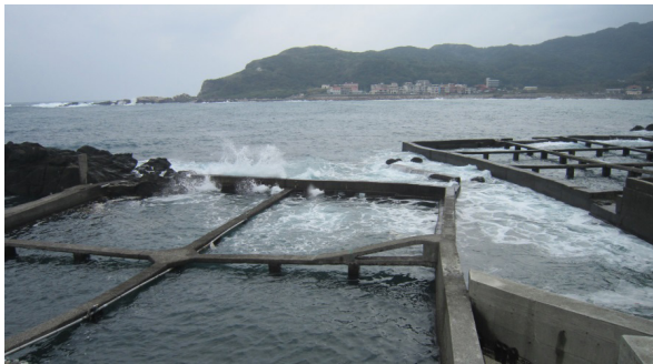
照片4 鼻頭角海蝕平台上廢棄的九孔養殖池，已受到海浪拍打侵蝕而不敷使用
