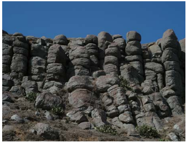
照片4 玄武岩邊坡經過風化侵蝕後，慢慢崩解。
